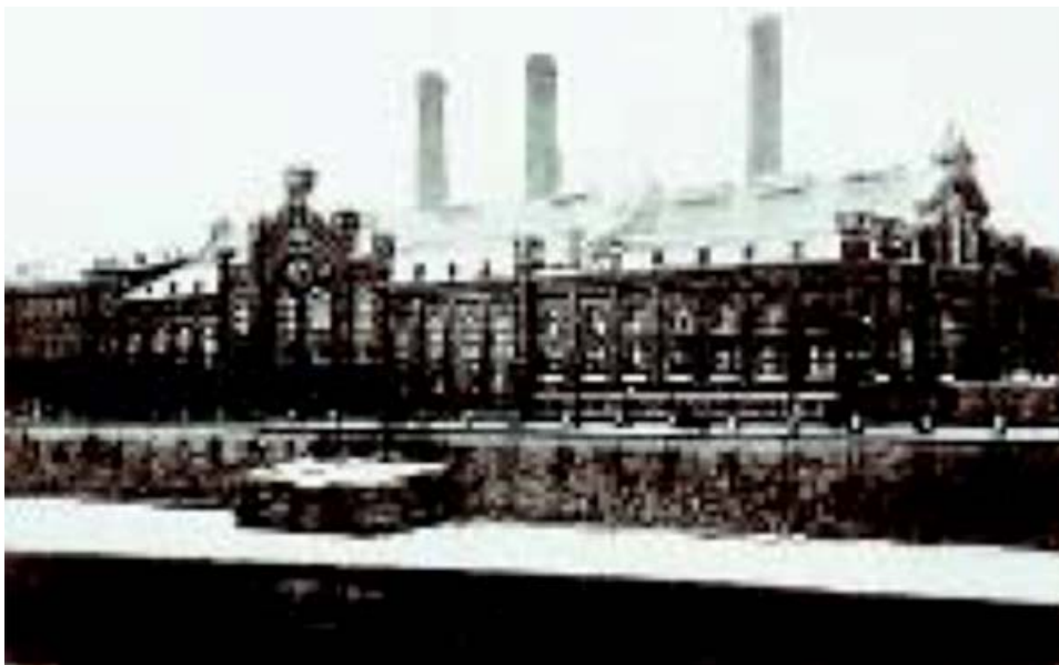
Электростанция на Раушской набережной в Москве (МОГЭС) функционирует с 1897 года
