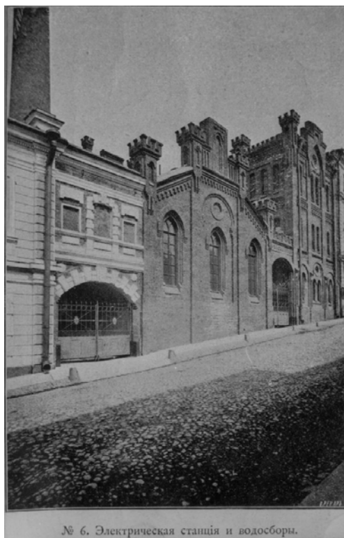
№ 6. Электрическая станция и водосбори.
