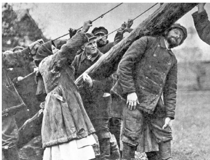
Установка электростолбов в деревне. 1927 год
