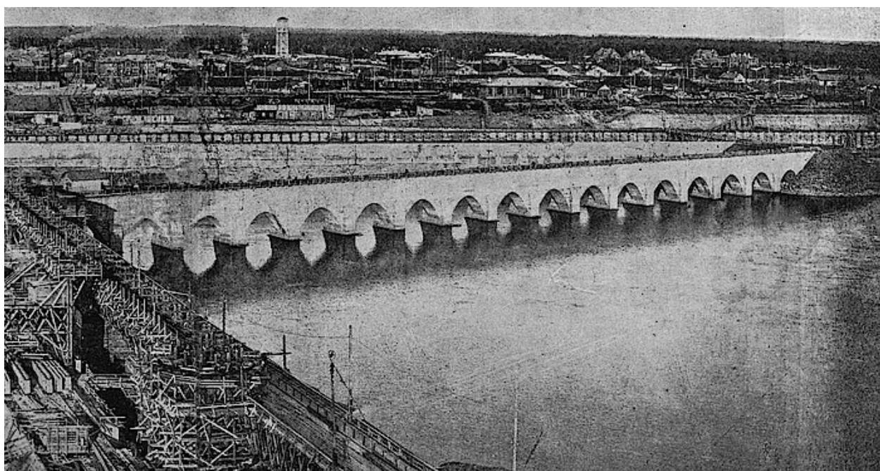
Лесозащитная стенка со стороны верхнего бьефа. Август 1925 г.
