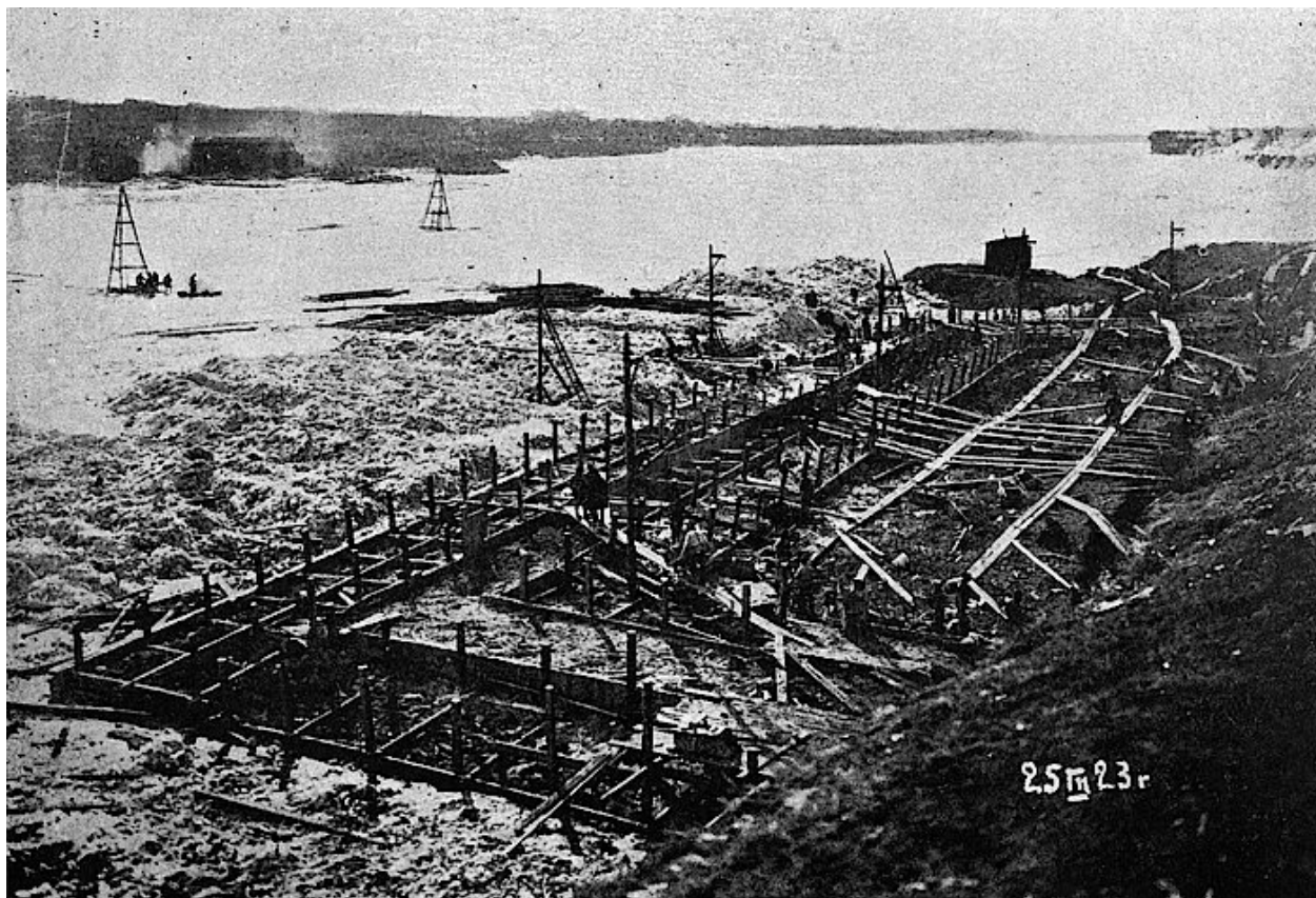
Постройка перемычки примыкания к левому берегу. 25 марта 1923 г.
