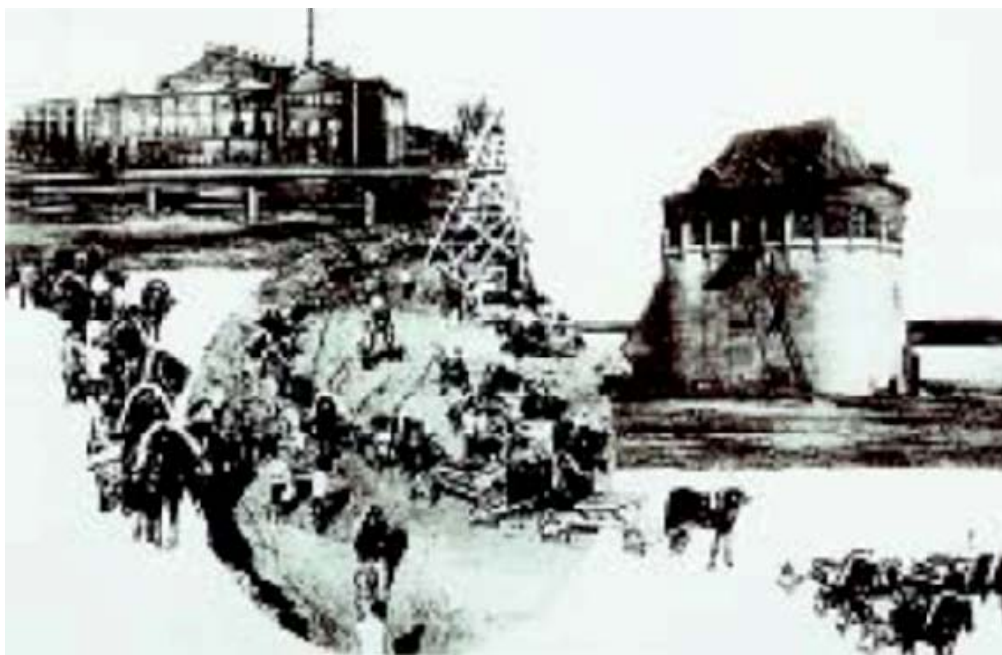
Начало строительства Каширской электростанции (фотомонтаж)
