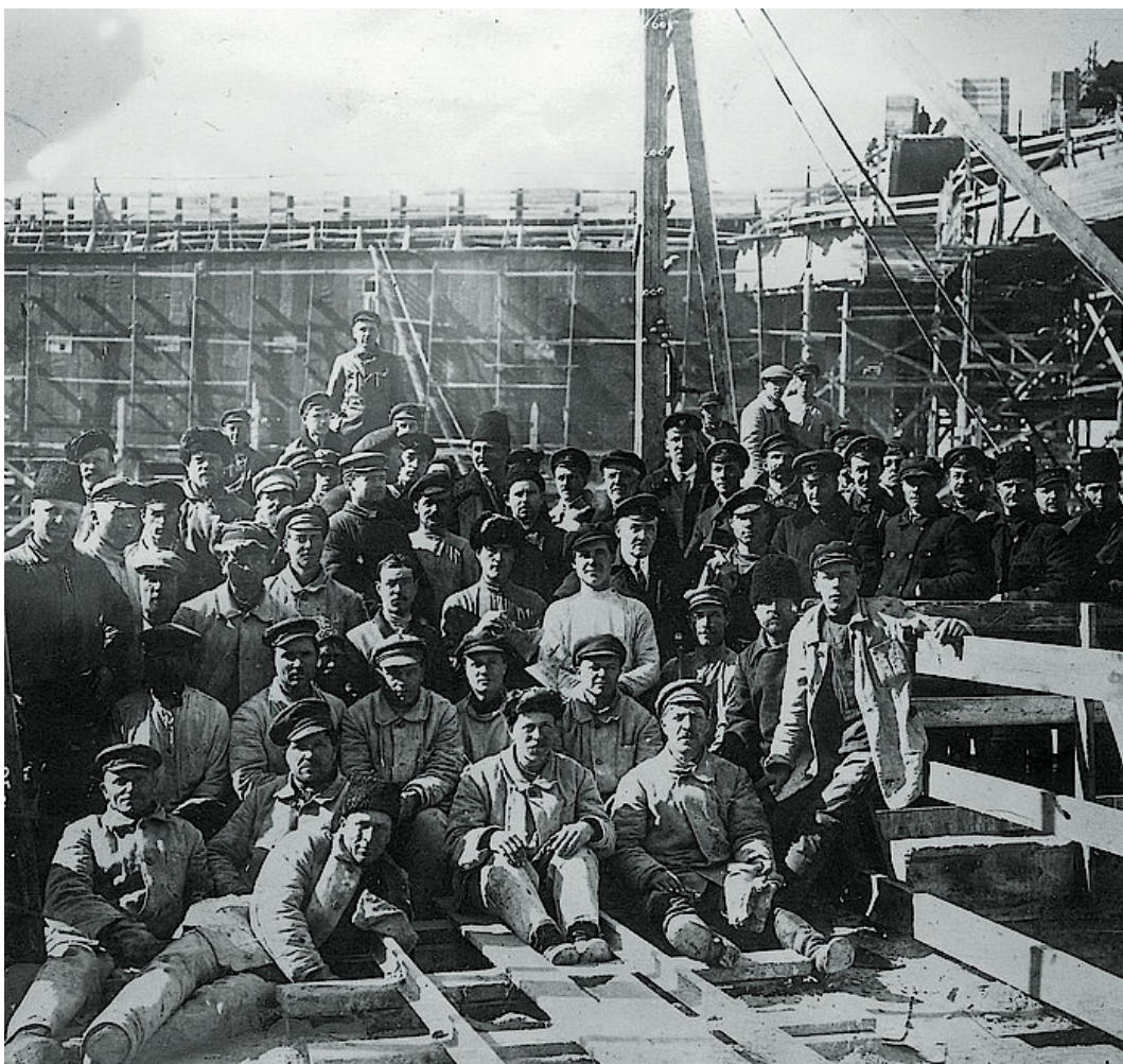
Рабочие на строительстве Волховской ГЭС
